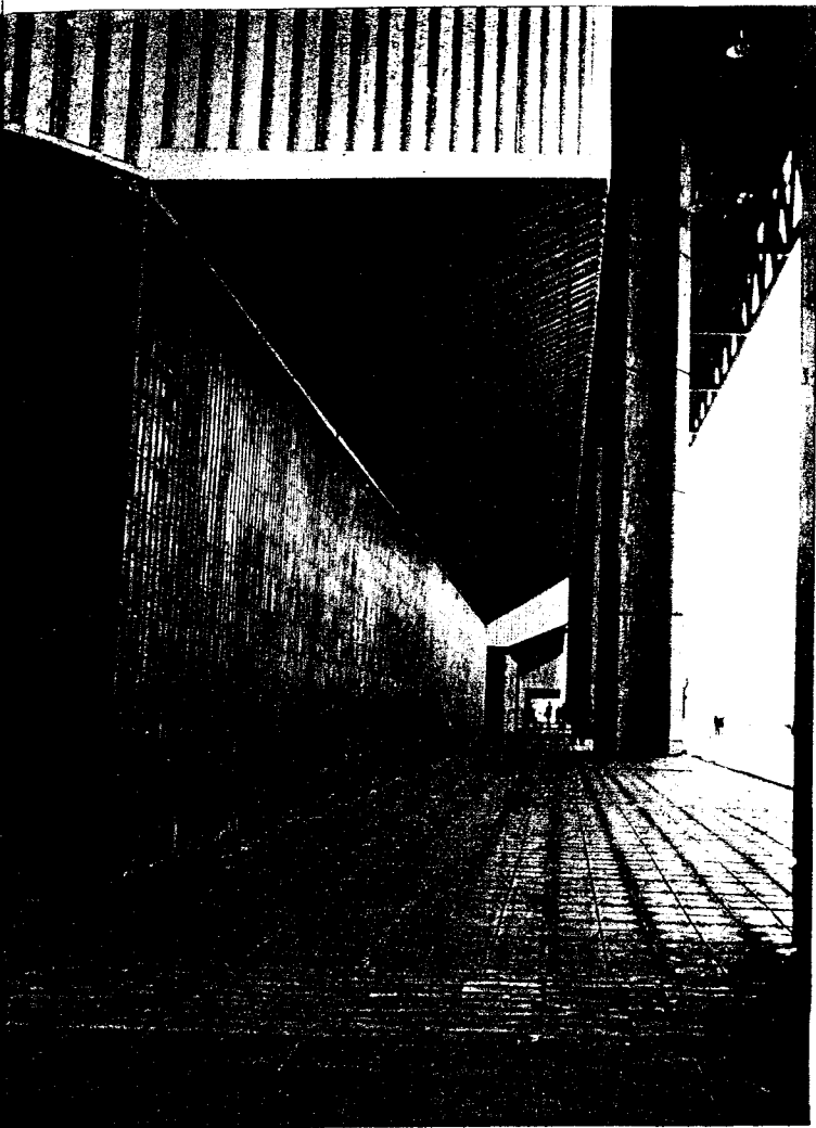
Vista de la amplia acera cubierta en el exterior de la placa por el costado de la Alameda
